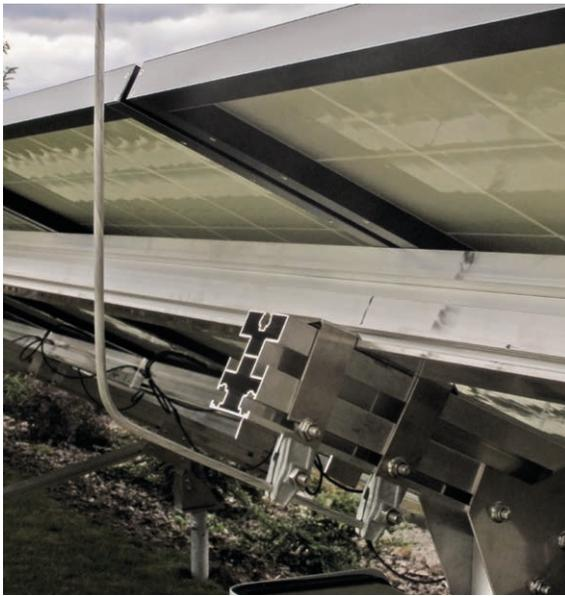
Bild 2 Blitzschutz mit DEHNiso-Befestigungshalter
