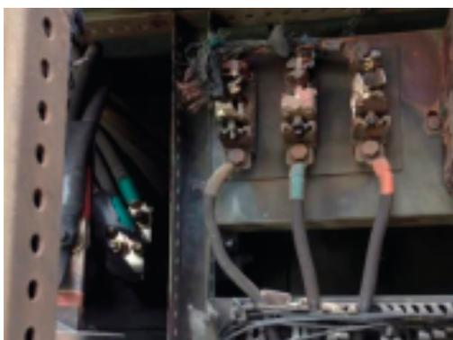
durch Impulsstrom explodierte Sicherungen
