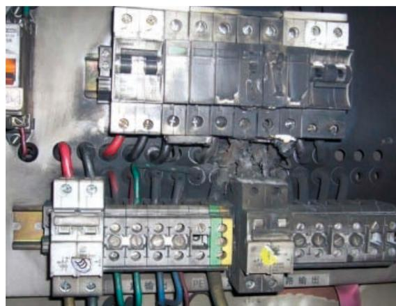
Bild 8 Überlastetes SPD und durch Fehlerstrom zerstörter Verteiler
