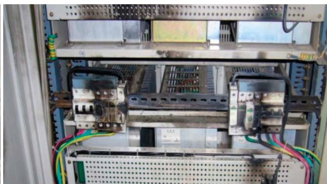
vom Impulsstrom zerstörte MCBs in einer Stromversorgung
