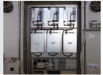
Im Prinzip besteht ein Frequenzumrichter aus einem Gleichrichter, einem Zwischenkreis, einem Wechselrichter und der Steuerelektronik (**Bild 1**).
