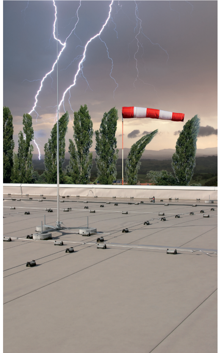
Hohe Windgeschwindigkeiten stellen besondere Anforderungen an die Fangeinrichtung.
