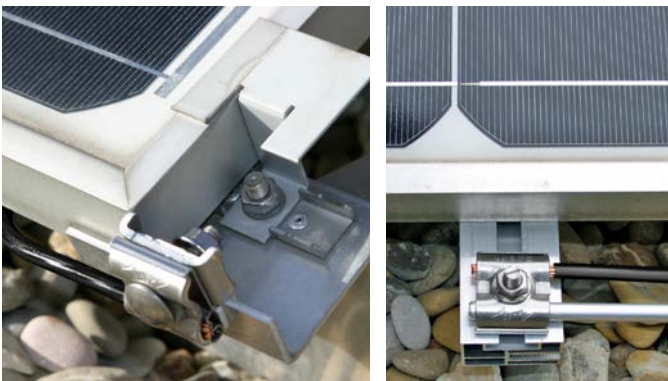
Funktionspotentialausgleich der Montagegestelle
