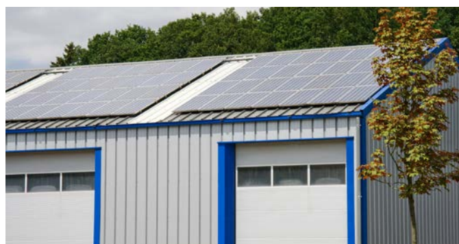
Stahlhalle mit durchgängiger Metallverkleidung und PV-Anlage
