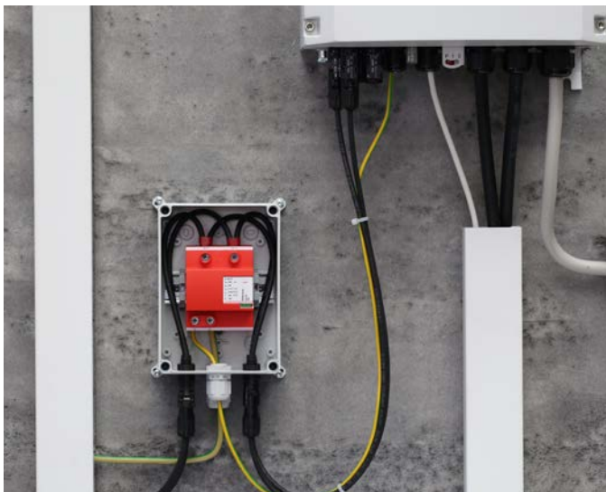
Generatoranschlusskasten DEHNcube 2 YPV (inkl. Kombi-Ableiter) zum Schutz der DC-Seite.
