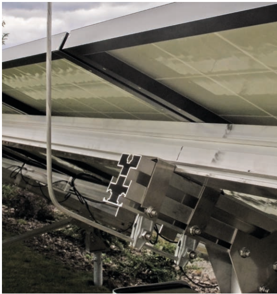
Bild 2 Blitzschutz mit DEHNiso-Befestigungshalter
