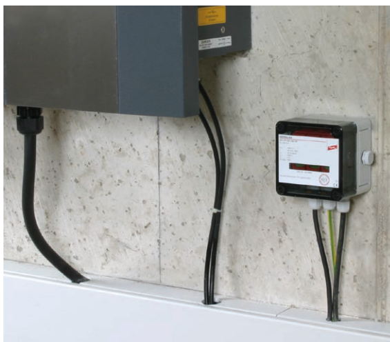
Bild 14 Typ 2-Ableiter DEHNcube YPV SCI 1000 1M zum Schutz von Wechselrichtern (1 MPPT)
