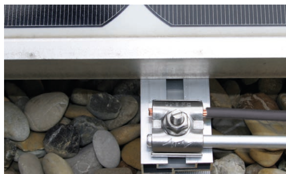
Bild 3 UNI-Erdungsklemme: Ein Edelstahl-Zwischenelement vermeidet Kontaktkorrosion. Dadurch werden langjährige sichere Verbindungen zwischen unterschiedlichen Leiterwerkstoffen geschaffen
