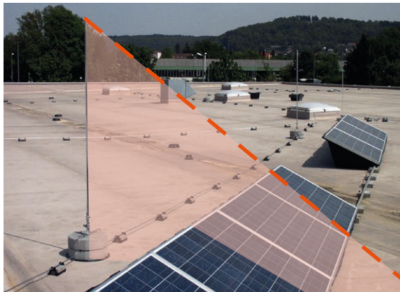
Bild 12 Ermittlung des Schutzraumes mittels Schutzwinkelverfahren
