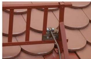
Metallene Dachaufbauten ab 2 m Länge
