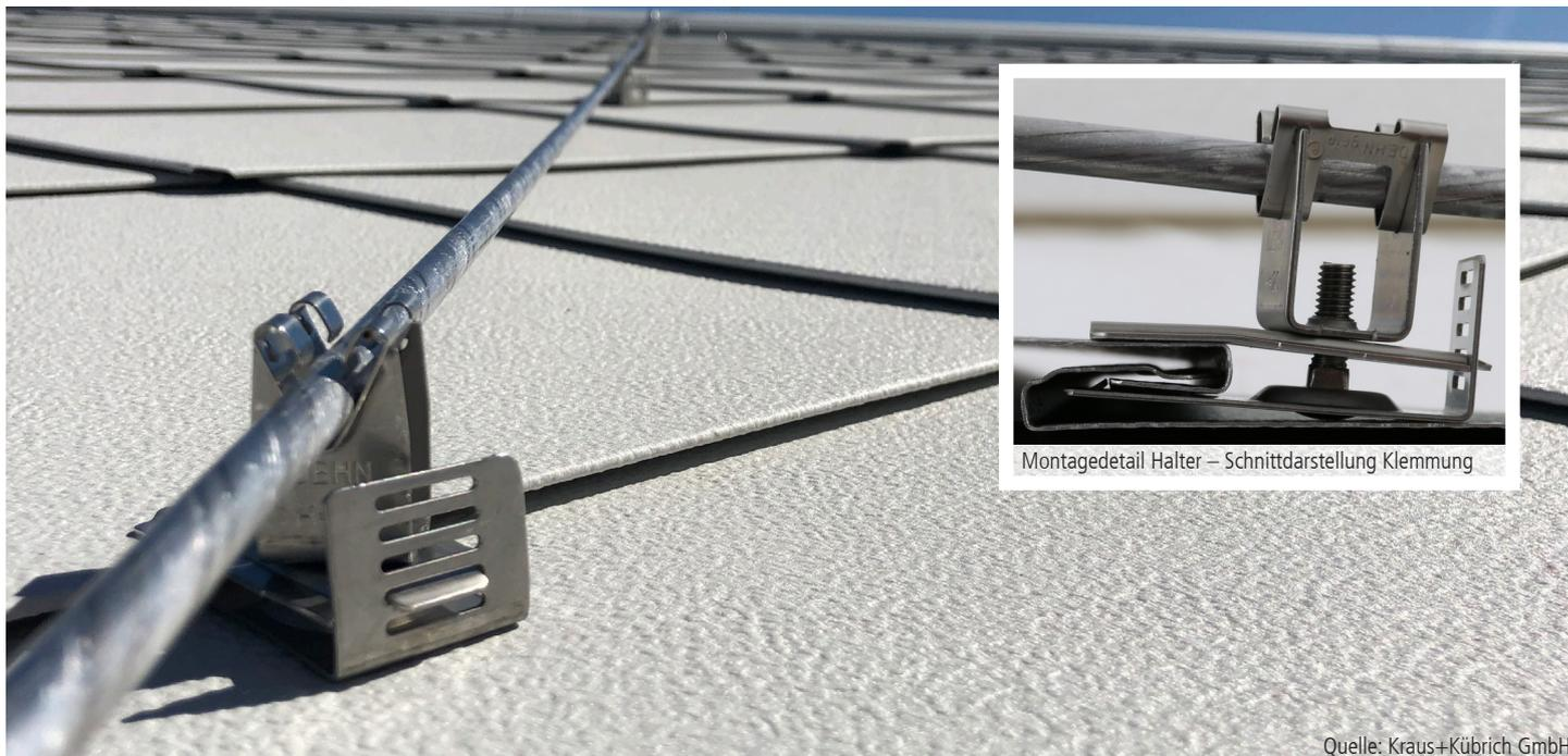
Montagedetail Halter – Schnittdarstellung Klemmung
