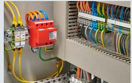
Die kleine Bauform schafft neue Möglichkeiten den vorhandenen Platz optimal auszunutzen. So ist auch der seitliche Einbau möglich, was es leichter macht, die 0,5 Meter Leitungslänge einzuhalten. Auch ein 180° gedrehter Einbau ist möglich.
