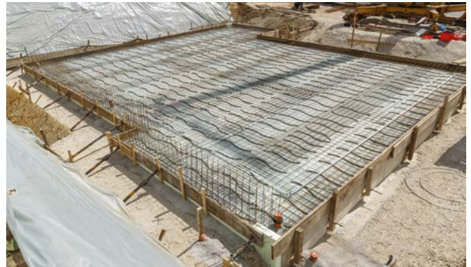
2) Darstellung der Teile einer Erdungsanlage - Beispiel eines Fundamenterders im Wohngebäude
