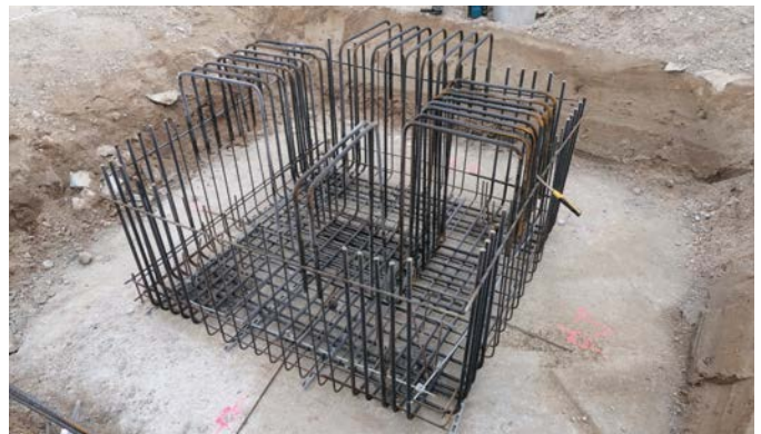
3b) Darstellung der Verbindungsleitung bzw. des Anschlusspunktes zur Anbindung von Einzel-fundamenten an die Erdungsanlage
