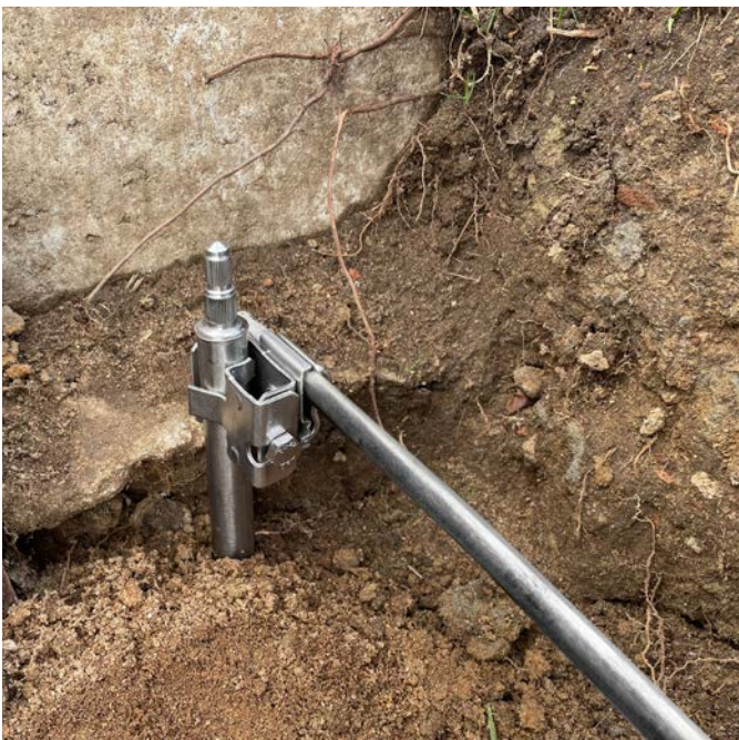
Fachgerechte Installation eines Tiefenerder NIRO (V4A)
