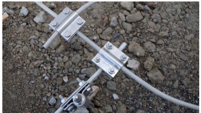
4b) Detailbilder von Verbindungen im Erdreich - Beispiel Anschluss Tiefenerder und Verbindungsleitung
