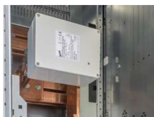
Löscheräte im eingebauten Zustand
