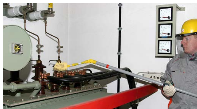
Feuchtreinigung eines Transformators mit dem Feuchtreinigungsset FRS ZK MS.
