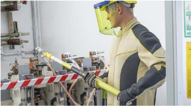
Anbringen einer EuK-Vorrichtung mit der notwendigen Schutzausrüstung.
