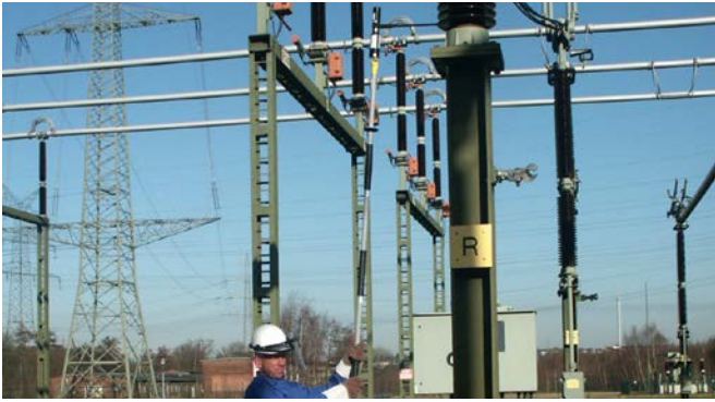
Abstands-Spannungsprüfer ASP in einer Freiluftschaltanlage.
