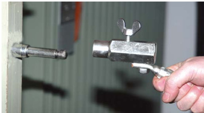
Erdungsfestpunkt mit Ringnut und Erdanschlussbuchse.
