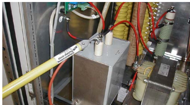
Einpolige Entladevorrichtung zum Ableiten statischer Ladungen.
