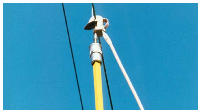
Einhängen der Fahrdrabt-Erdungsklemme in den Fahrdrabt.
