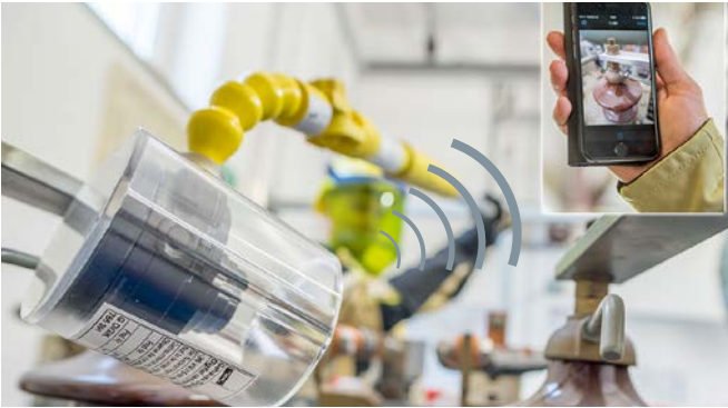
Rückseitige Kontrolle eines Isolators ohne Freischaltung.
