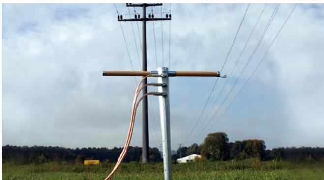
Erdungsrohr mit montierter Erdungsschiene und Erdungsseilen.
