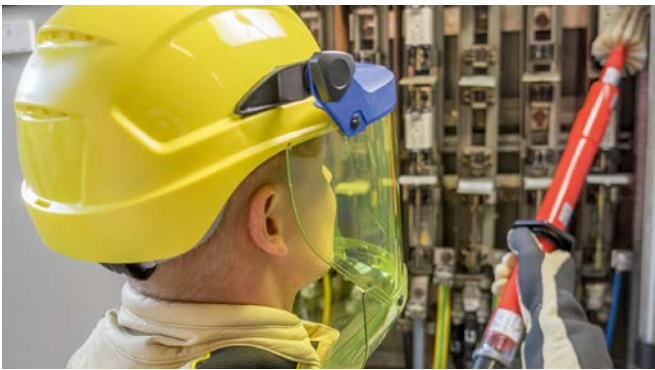
Monteur mit notwendiger Schutzausrüstung.
