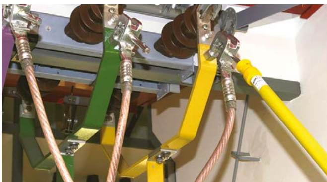
Einbringen einer Erdungs- und Kurzschließvorrichtung mit einer Erdungsstange.
