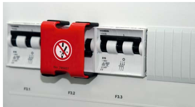
Sperrelement mit 3 Teilungseinheiten (3 TE).
