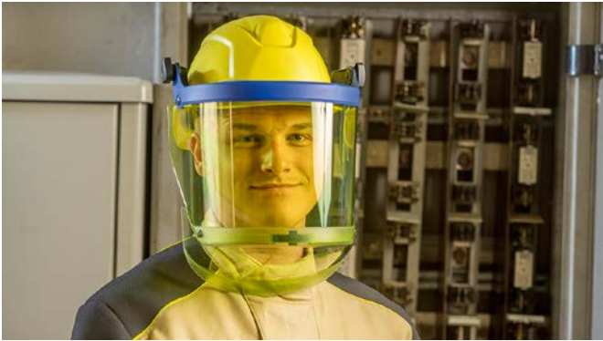
Monteur in einer Niederspannungsschaltanlage.
