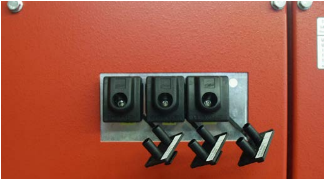
Passives Spannungsanzeigegerät DEHNcap/P an einer gekapselten Schaltanlage.
