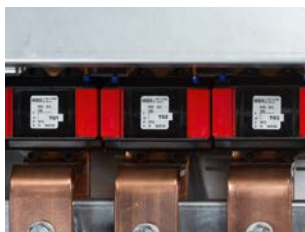
Eingebaute Schutzstromwandler
