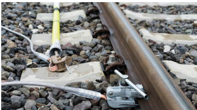
Schienenanschlussklemme am Schienenprofil montiert.
