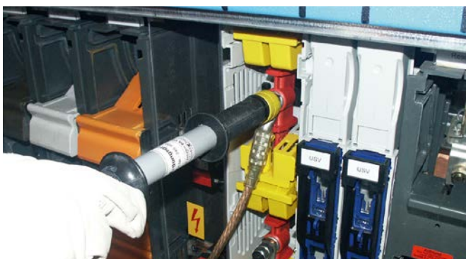
Einsetzen der teilisolierten Erdungs- und Kurzschließvorrichtung mit Hilfe des Erdungsgriffes TI.
