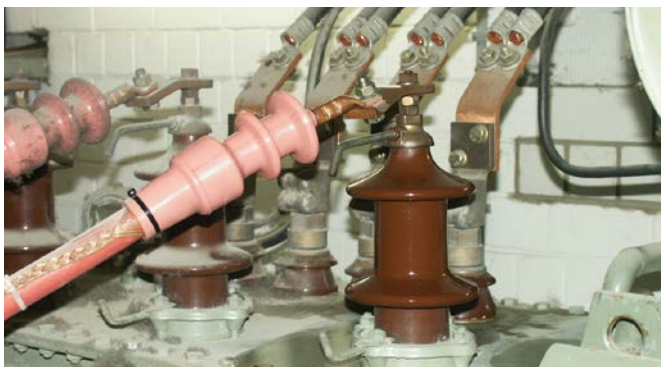
Im Vordergrund gereinigter Isolator.
