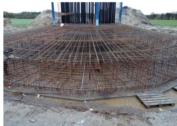
Bild 3 WEA-Bewehrung mit Fundamenterder
