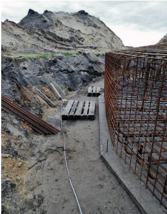
Bild 8 WEA-Bewehrung mit erdfühlig verlegtem Ringerder
