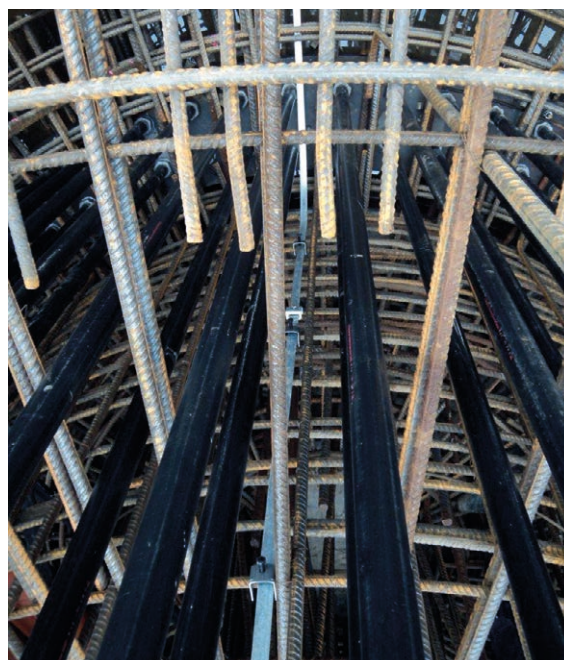
Bild 6 Verbindung des Erders mit der Bewehrung
