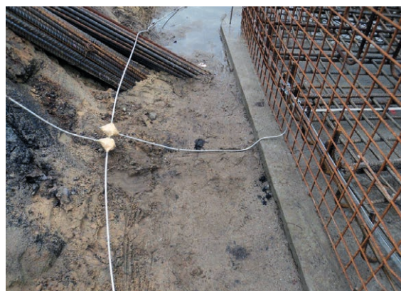
Bild 7 Ringerder mit Verbindung zum Fundamenteerder
