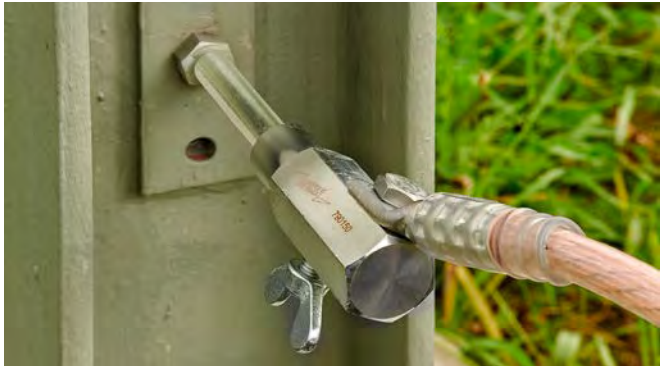
Erdungsfestpunkt mit Ringnut und Erdanschlussbuchse.
