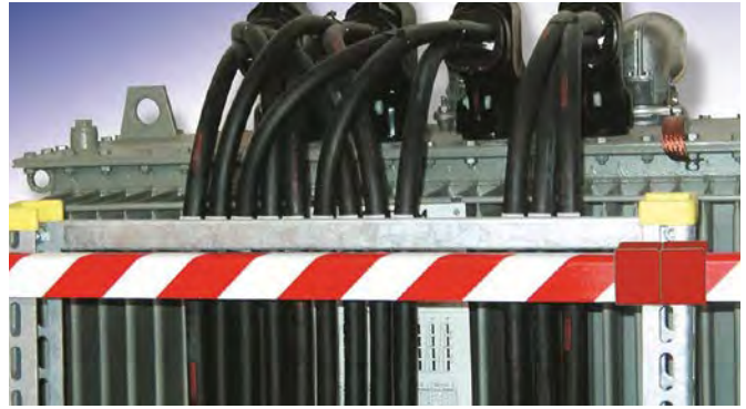
Absperrbalken montiert in Trafostation.
