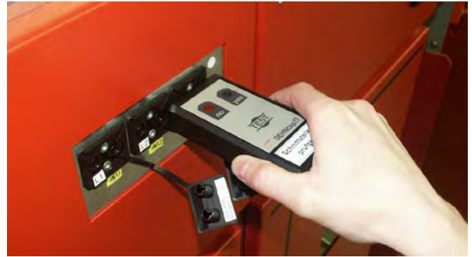
Schnittstellenprüfgerät DEHNcap/IT ermöglicht die Wiederholungsprüfung an Koppelteilen von Schaltanlagen entsprechend DIN VDE 0682-415 (IEC/EN 61243-5).
