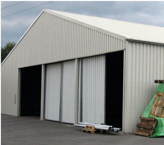
Bild 4 Stahlhalle mit Metallverkleidung
