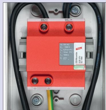
Bild 9: Blitzstromtragfähiges SPD Typ 1 zum Schutz der DC-Seite des Wechselrichters bei nicht eingehaltenem Trennungsabstand zwischen Blitzschutzanlage und PV-System
