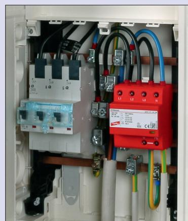
Bild 10: Blitzstromtragfähiges SPD Typ 1 zum Schutz der AC-Seite des Wechselrichters bei nicht eingehaltenem Trennungsabstand zwischen Blitzschutzanlage und PV-System (Quelle: DEHN + SÖHNE)
